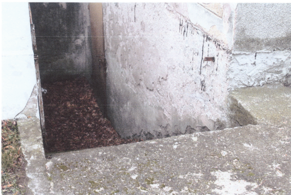
Fot. 5. Widok wejścia do piwnicy.
