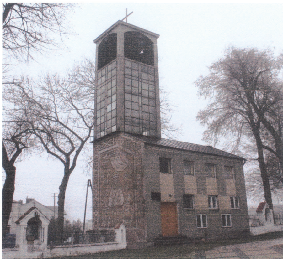
Fot. 1. Widok ogólny elewacji frontowej (zachód) i elewacji szczytowej (południe) z sgraffito.
