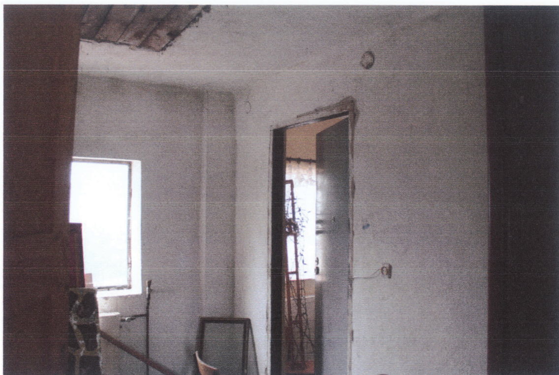
Fot. 3. Wnętrze budynku.
