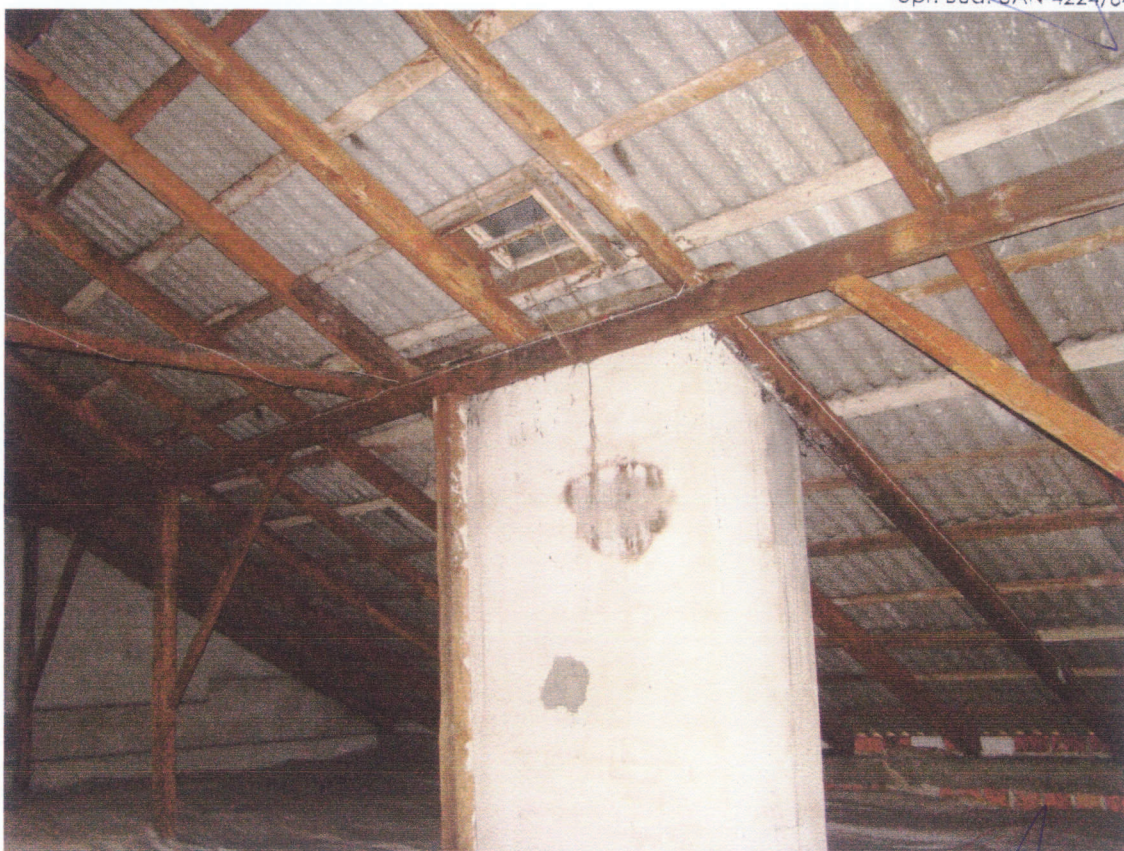
Fot. 4. Więźba dachowa i widok komina.
