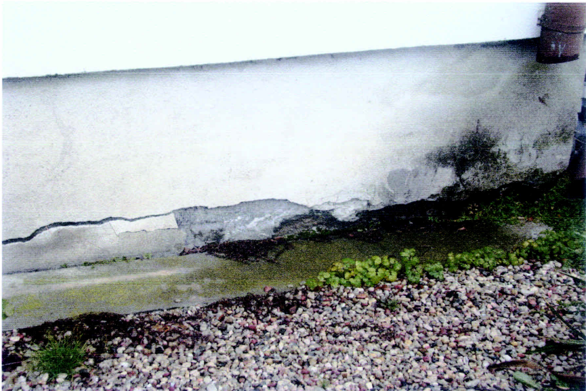
Fot. 5. Widok stanu zachowania dolnych partii budynku
