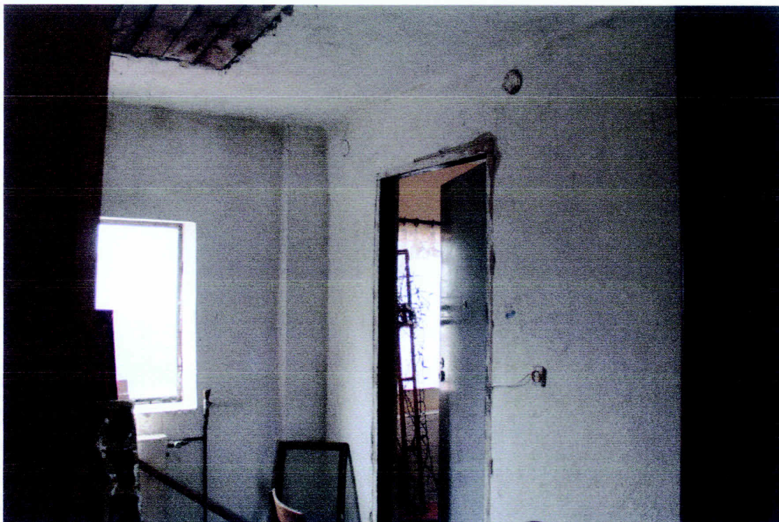
Fot. 3. Wnętrze budynku.
