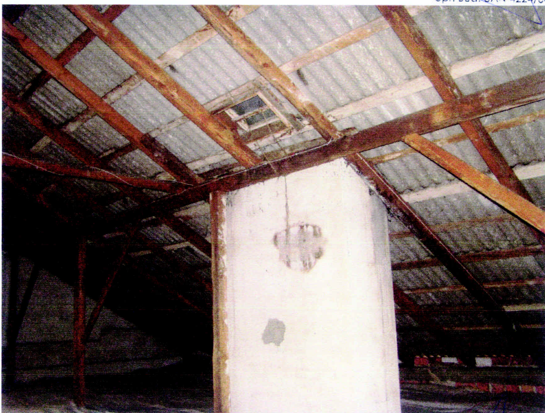
Fot. 4. Więźba dachowa i widok komina.
